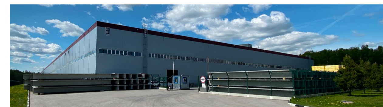
Новый объект фонда: Завод ЖБИ
